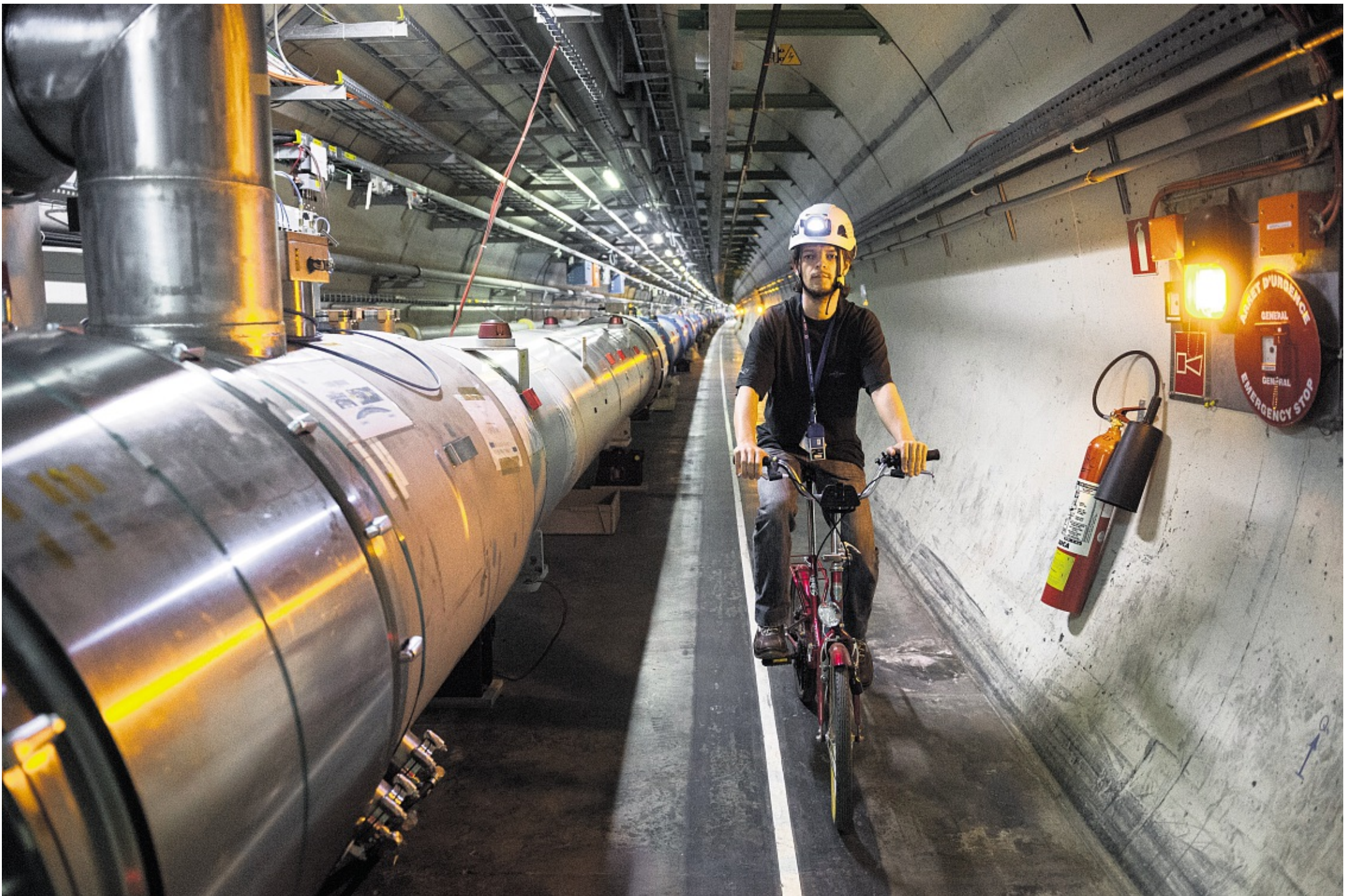
Le Grand Collisionneur de hadrons (LHC) du CERN, près de Genève, forme, à 100 mètres de profondeur, un anneau de 27 kilomètres de circonférence. ANDRI POL/FOCUS/COSMOS
